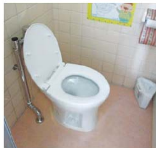
和式便器を洋式便器に改修
