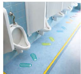
トイレの床面のシート貼り
