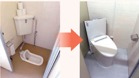
改修前後の様子
