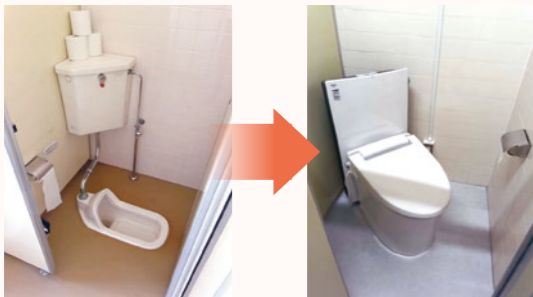
改修前後の様子
