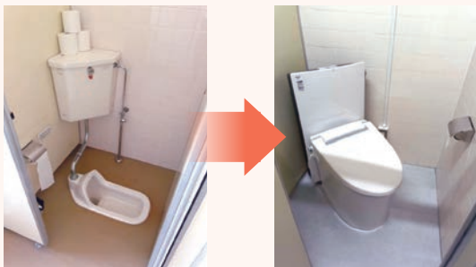
改修前後の様子
