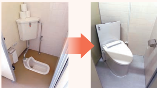
改修前後の様子
