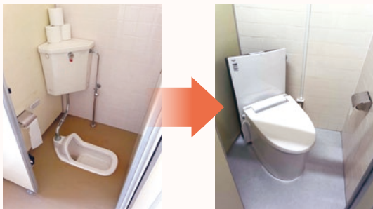
改修前後の様子
