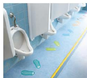
トイレの床面のシート貼り
