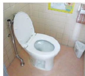
和式便器を洋式便器に改修
